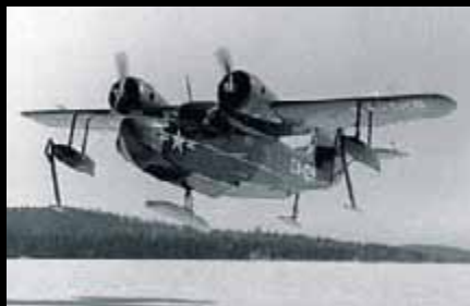
Curiosa riconversione di un anfibo Grumman "Goose" in aereo con gli sci, per operazioni su superfici innevate.
